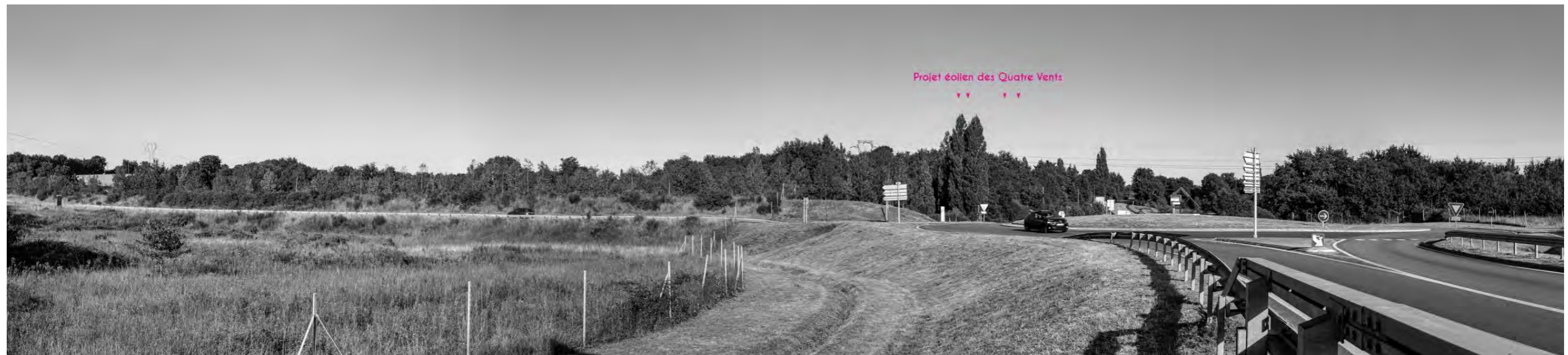
Figure 234 : PM7 – Vue depuis la D746 en sortie de l'agglomération yonnaise (au niveau du pont au-dessus de l'A87)
