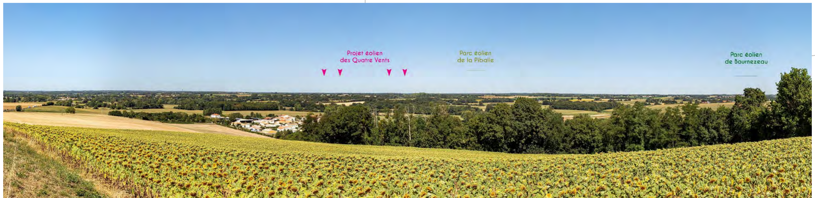
Figure 253 : PM23 – Vue depuis la D19 au droit de Sainte-Pexine
