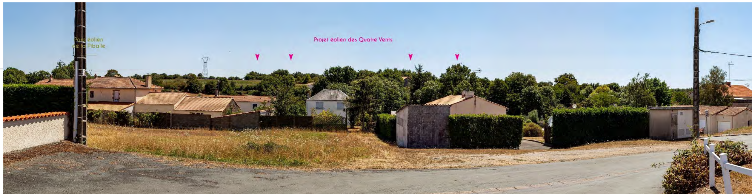
Figure 238 : PM10 – Vue depuis la Rue de la Belle entrée au centre du bourg de Thorigny
