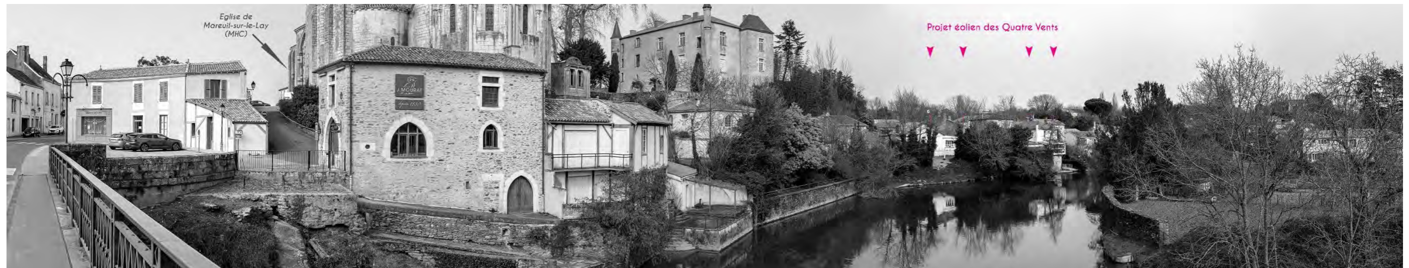
Figure 261 : PM29 – Vue depuis le pont sur le Lay au centre de Mareuil-sur-le-Lay
