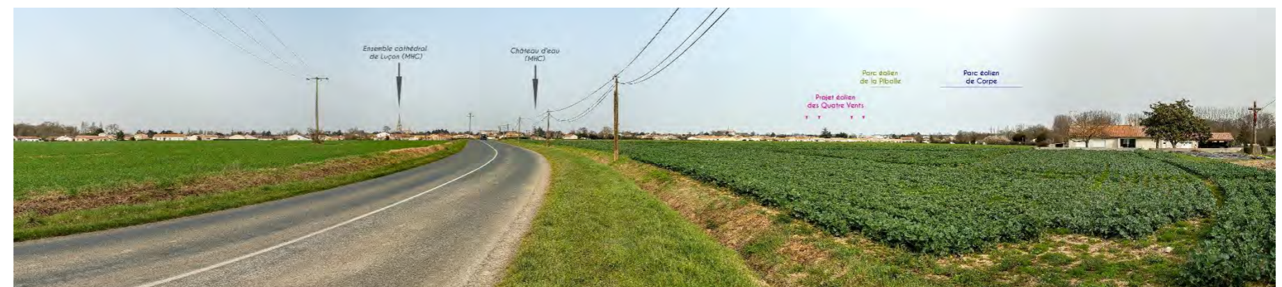
Figure 229 : Rappel du PM4 – Vue depuis la D50 à l'entrée Sud-est de Luçon
