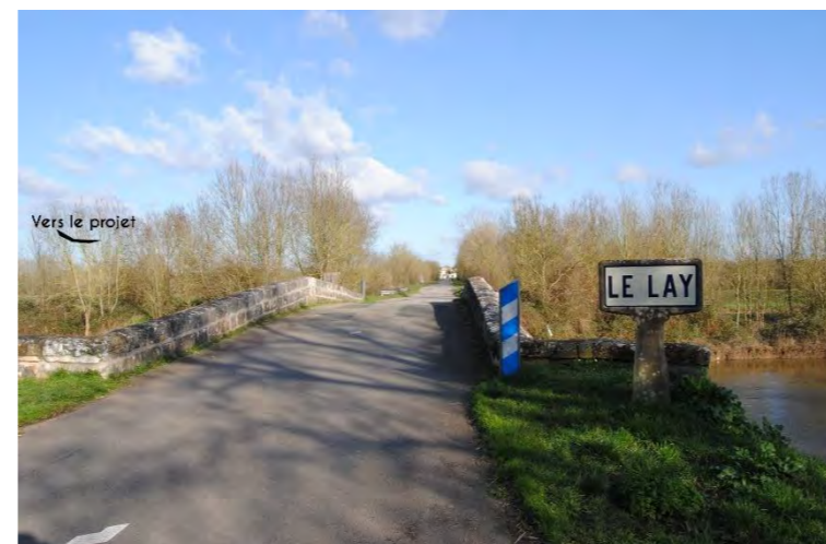
Figure 225 : Vue depuis le pont sur le Lay à Port-la-Claye
