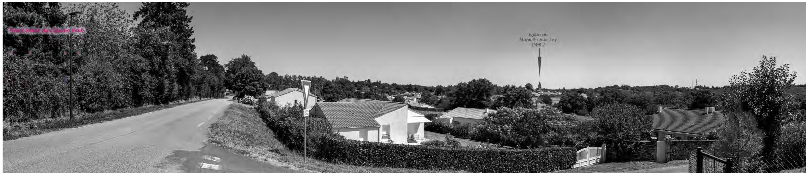
Figure 262 : PM30 – Vue depuis la Rue de Saint-André au droit du Château de St-André
