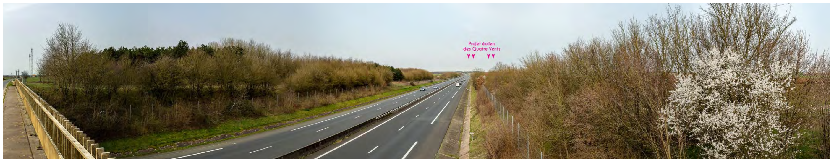
Figure 235 : PM8 – Vue depuis la D10 au niveau du pont au-dessus de l'A83 (au droit de St-Etienne-de-Brillouet)
